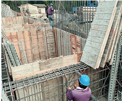
各水箱間相通管預留 預留管周邊鋼筋補強
