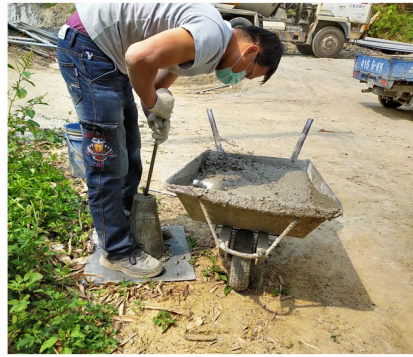
混凝土抽樣檢驗
