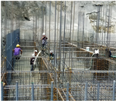
基礎版灌漿作業
