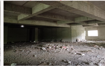
地下室拆模後整理
