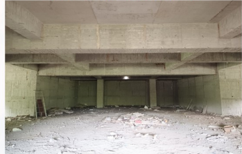
地下室拆模後整理
