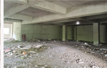
地下室拆模後整理
