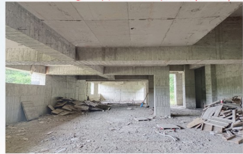
地下室拆模後整理
