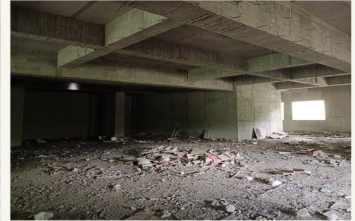
地下室拆模後整理
