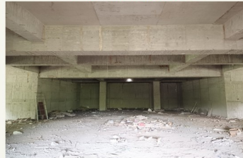
地下室拆模後整理
