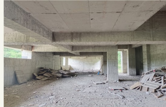
地下室拆模後整理
