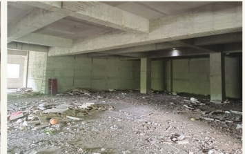
地下室拆模後整理
