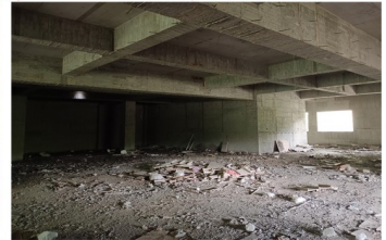
地下室拆模後整理
