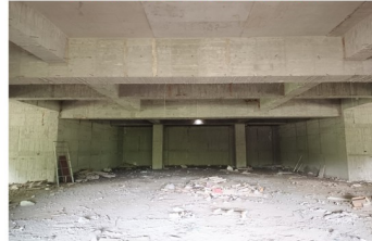
地下室拆模後整理
