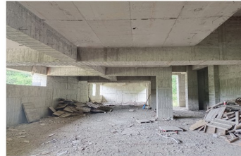
地下室拆模後整理
