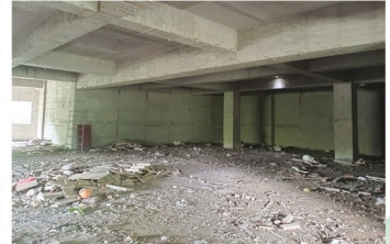
地下室拆模後整理
