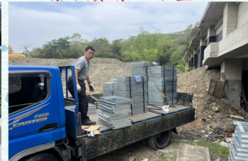
鍍鋅維修人孔蓋進場
