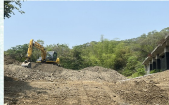
前方廣場土方整理
