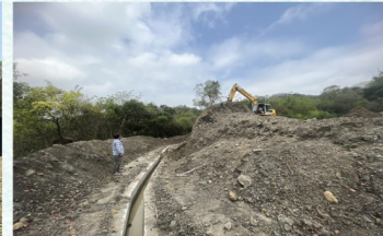
前方廣場土方整理
