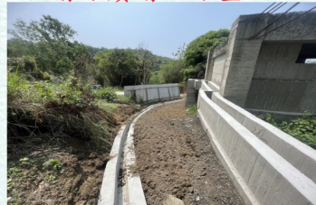
前方廣場土方整理
