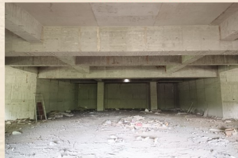
地下室拆模後整理
