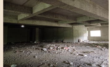
地下室拆模後整理
