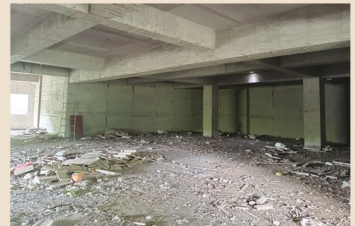
地下室拆模後整理
