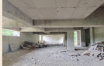
地下室拆模後整理
