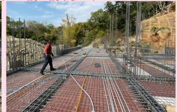
水電配管完成
