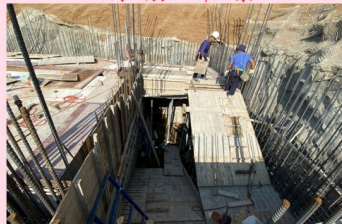
揮汗組立樓梯模板
