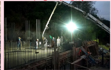
挑燈澆置混凝土
