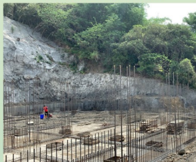
筏基土壤回填夯實
