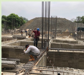
地梁側模拆除
