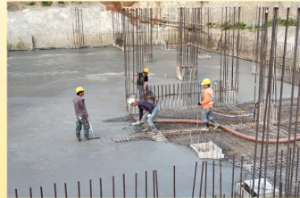
混凝土抽樣品管作業
