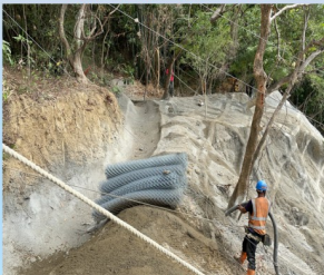
邊坡噴漿作業
