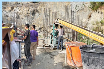
邊坡噴漿作業
