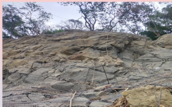
鋼線網鋪設
