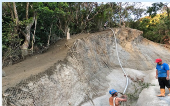
邊坡噴漿作業
