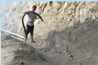
邊坡噴漿作業
