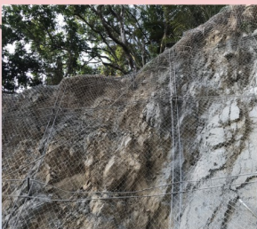
鋼線網鋪設
