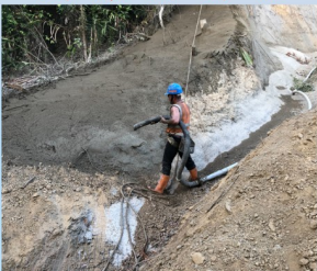
邊坡噴漿作業
