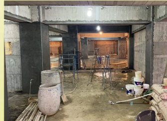
建廟工程集錦 - 地下二樓粉刷工程
