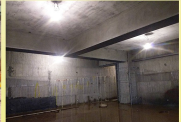
建廟工程集錦 - 地下二樓粉刷工程
