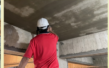
建廟工程集錦 - 地下二樓粉刷工程
