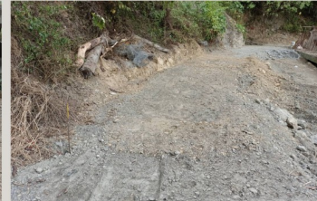
排水設施，放樣、開挖
