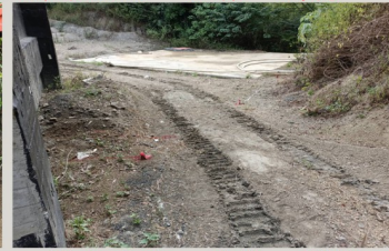
排水設施，放樣、開挖
