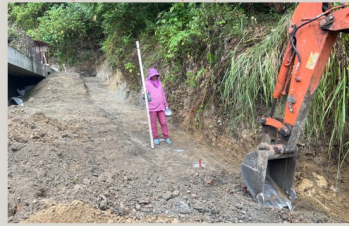
排水設施，放樣、開挖
