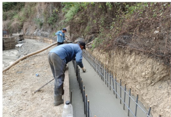
建廟工程集錦-水保工程-排水設施-底座灌漿
