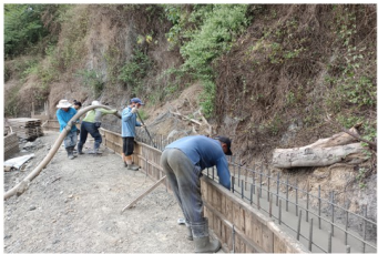
建廟工程集錦-水保工程-排水設施-側模組立
