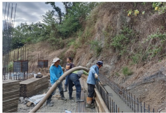
建廟工程集錦-水保工程-排水設施-側模組立
