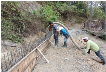
建廟工程集錦-水保工程-排水設施-底座灌漿
