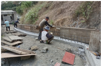
建廟工程集錦-水保工程-排水設施-側模組立
