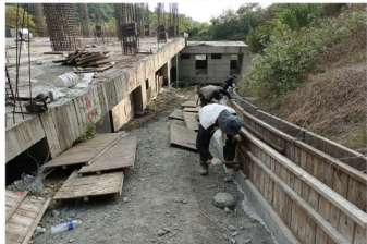
建廟工程集錦-水保工程-排水設施-側模組立
