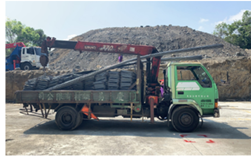
擋土牆鋼筋進場
