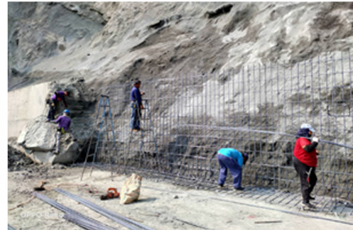
擋土牆鋼筋組立
