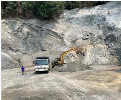
邊坡土石清運
