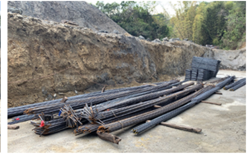
擋土牆鋼筋進場
