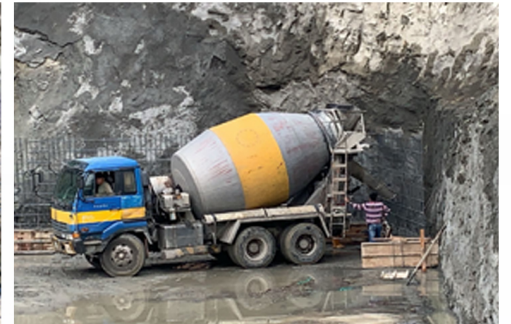
擋土牆基礎灌漿
