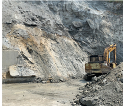
邊坡土石清運
