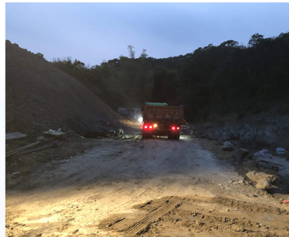
挑燈夜戰施工
