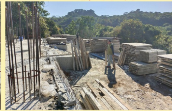
整理一樓模板
