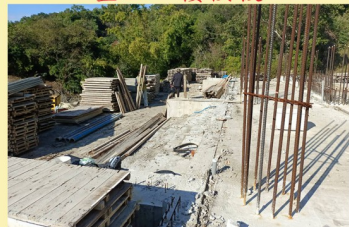
整理一樓模板
