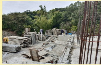
整理一樓模板
