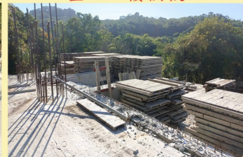
整理一樓模板
