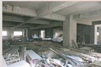
拆模後模板整理
