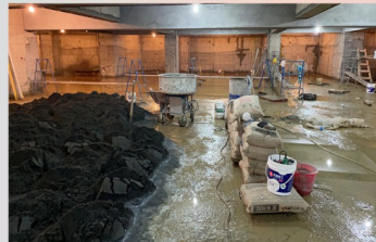
地下二樓樓板、樑粉刷
