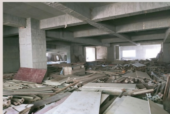
拆模後模板整理
