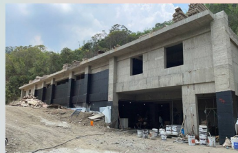
地下一樓外牆防水完成
