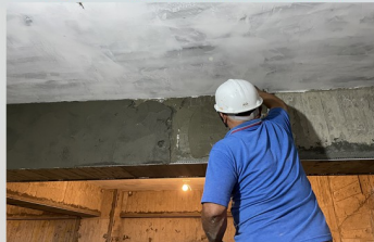
地下二樓樓板、樑粉刷
