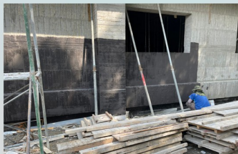
地下一樓外牆防水施作
