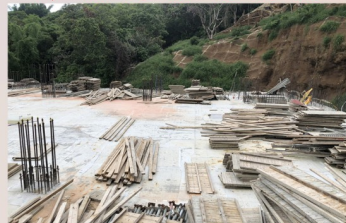
拆模後模板整理
