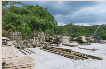
拆模後模板整理
