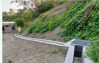
水溝工程施工
