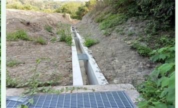
水溝工程施工
