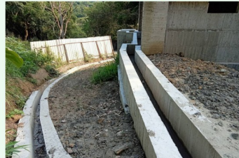
水溝工程施工
