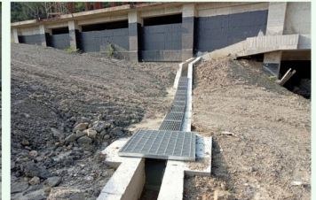
水溝工程施工
