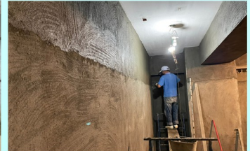
地下二樓防水工程
