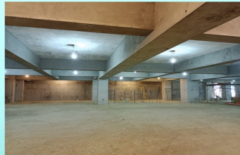
地下二樓防水工程完成
