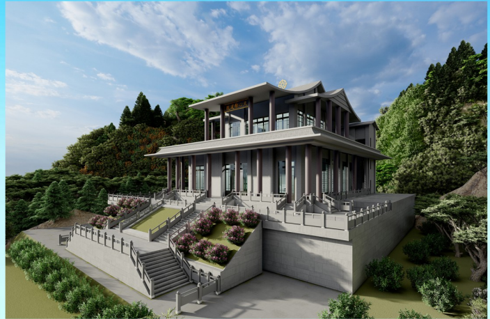
建廟工程集錦 - 地下二樓
