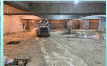
地下二樓環境整理
