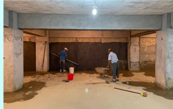
地下二樓防水工程
